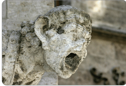
Asit yağmurları tarihi eserlere zarar verir.
